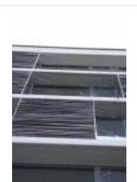
Versponnene Fassaden am Kaiserkai 3
